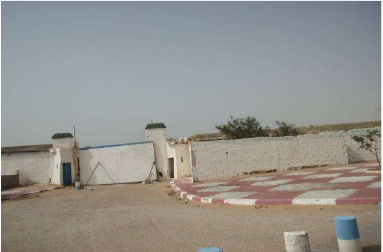
Estado de la entrada del antiguo Cabrerizas en el 2009. Los marroquíes la han “retocado” a peor.
