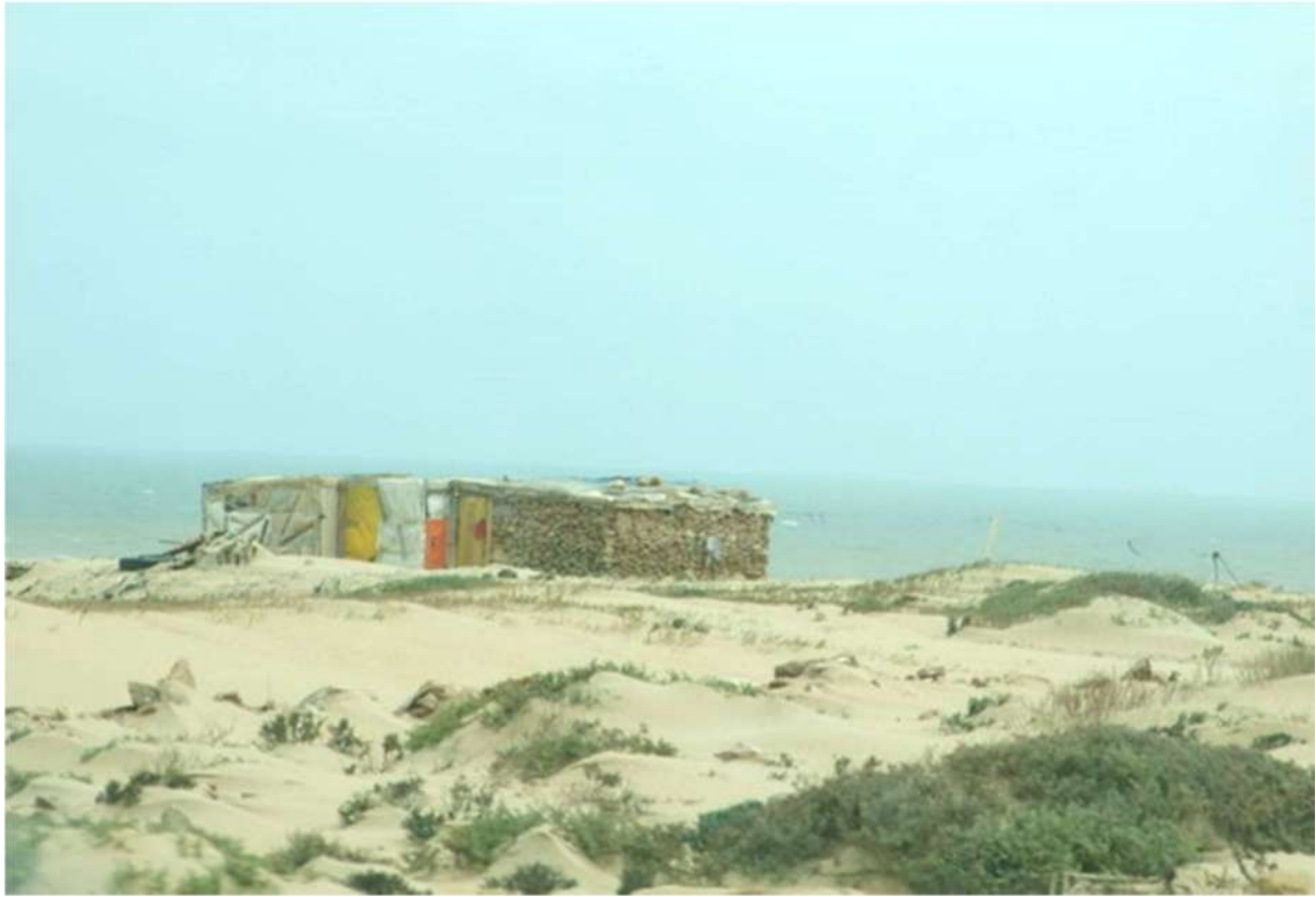
“Vivienda” frente al mar.
