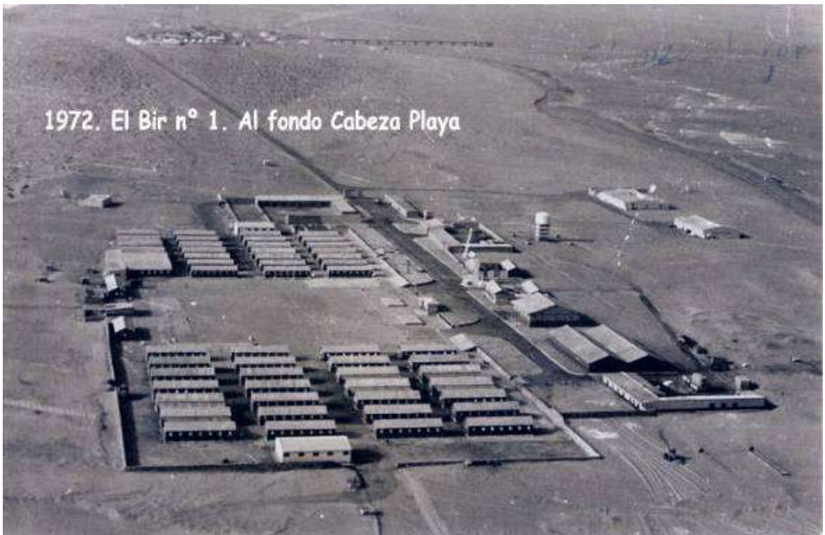
El BIR en el 1972, al fondo se aprecia las edificaciones de Cabeza Playa y el espigón.
